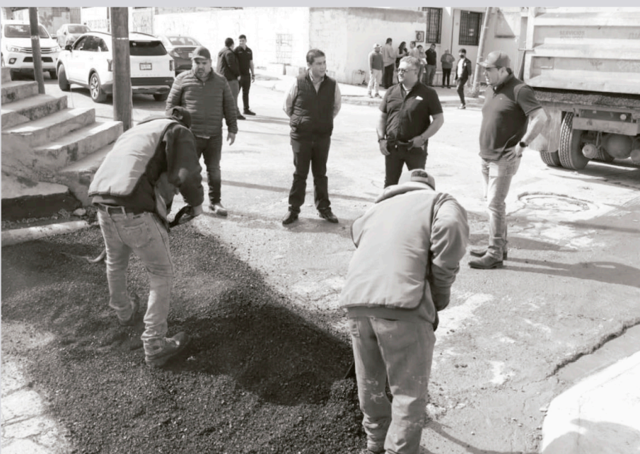
Francisco Treviño Cantú, alcalde de Juárez supervisando los trabajos de bacheo.
